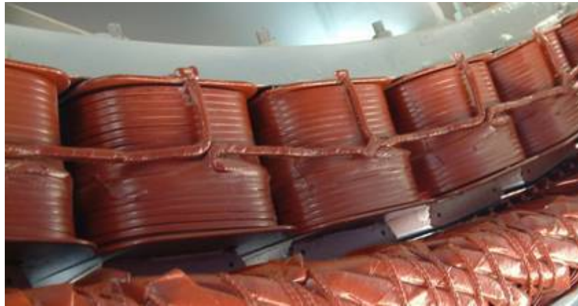
Figura 4.19 – Detalhe dos polos magnéticos do gerador síncrono modelado.
