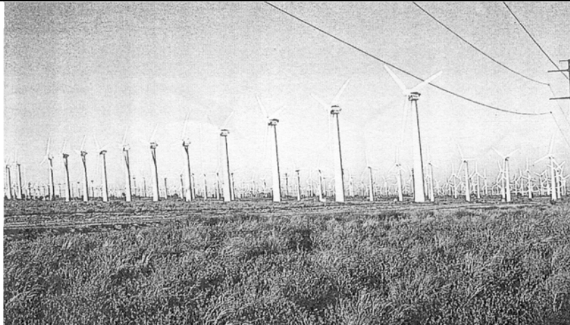
Figura 3.4 – Exemplo de um parque eólico na Califórnia, composto por aerogeradores com potência individual de 250 kW.
