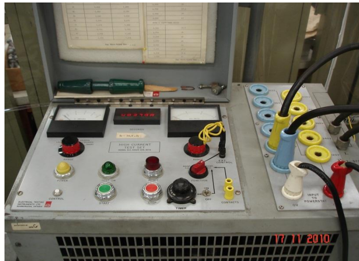
Figura 52 – Fonte de alta corrente utilizada nos ensaios com o limitador no CEPEL (Ilha do Fundão).
