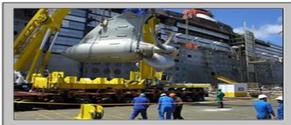
Figura 2.12 – Instalação de hélices tipo POD no navio civil Queen Mary 2 [24].
