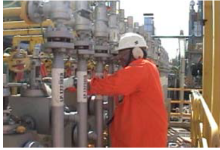
Figura 1.5: Exemplo de operação em plataformas de petróleo que necessita de cooperação entre dispositivos robóticos. Devido a posição da válvula é necessário utilizar duas mãos para acioná-la de forma eficiente. Retirado de (Remiro 2009).
