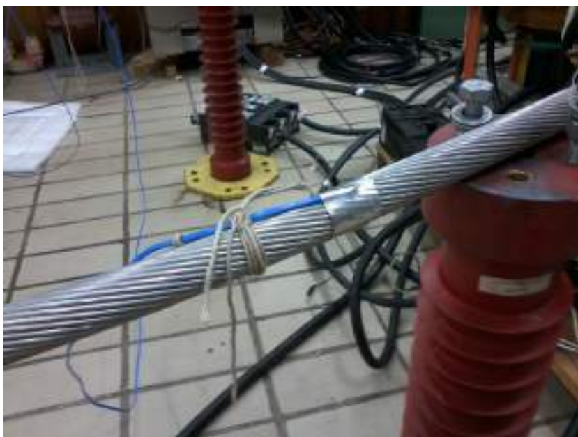
Figura 3.18. Detalhe da instalação dos termopares no cabo.
