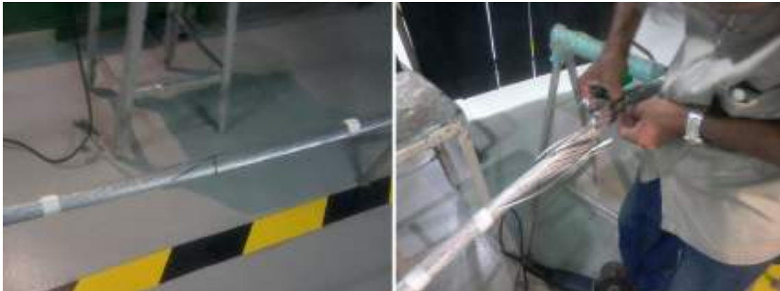
Figura 3.11. Cabo Duck com a região de corte demarcada e, após o corte, tendo os condutores manualmente separados.
