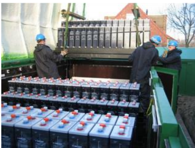
Figura 3.9 – Instalação do banco de baterias, MR em Bronsbergen, Holanda [33]
