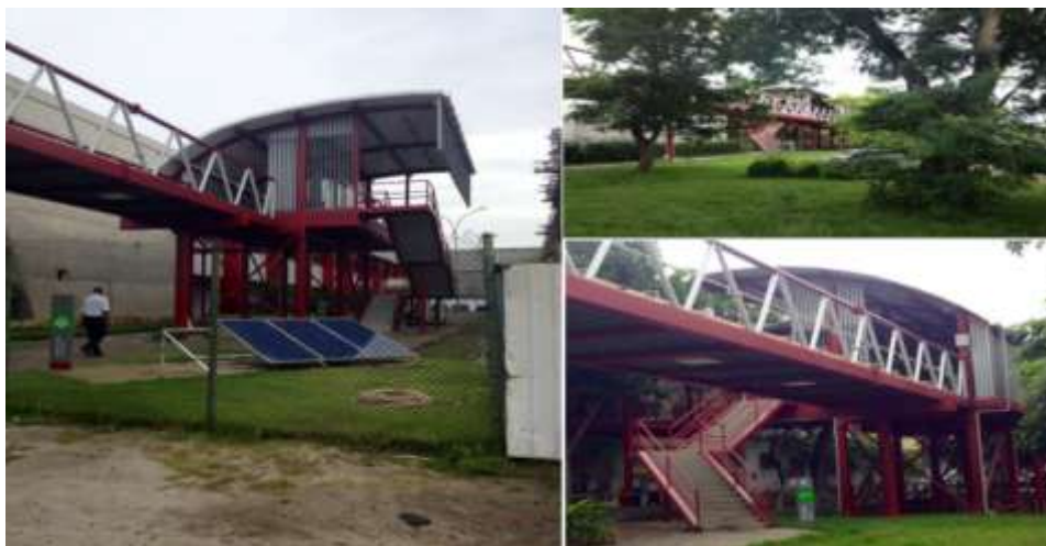
Figura 4.9: Obra concluída (Fonte: O autor).
