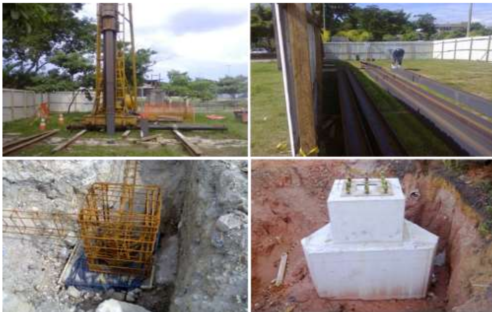
Figura 4.17: Materiais regionais utilizados nas fundações (Fonte: O autor).
