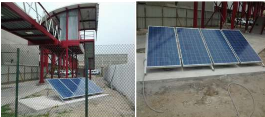
Figura 4.13: Painéis fotovoltaicos, suprem as necessidades operacionais do MagLev-Cobra , além de injetar o excedente de energia à rede de distribuição (Fonte: O autor).
