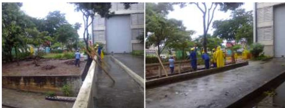
Figura 4.8: Início da implantação do canteiro de obras (Fonte: O autor)
