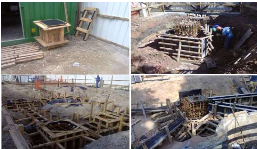
Figura 4.16: Reuso de material no canteiro de obras, forma dos blocos das fundações (Fonte: O autor).
