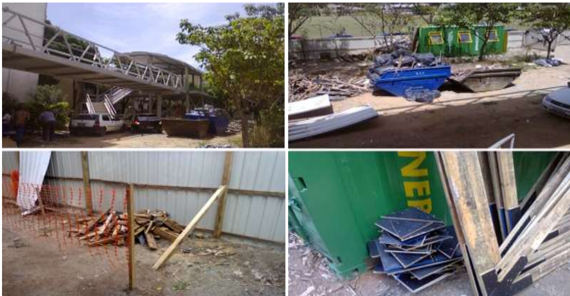
Figura 4.15: Materiais de descarte e reuso no canteiro de obras (Fonte: O autor).
