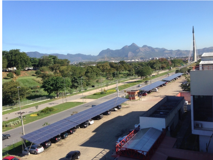
Figura 2.2: Conjunto de Painéis Solares Fotovoltaicos - Estacionamento Solar UFRJ - Fonte: Fundo Verde. Disponível em: http://www.fundoverde.ufrj.br .
