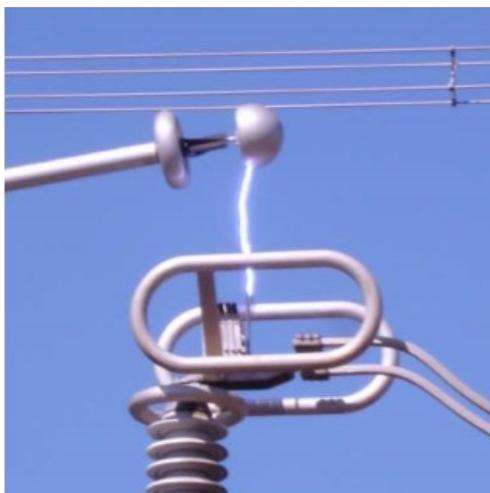
Figura 2.8 - Arco elétrico formado entre os polos de uma chave seccionadora durante uma manobra<sup>[17]</sup>
