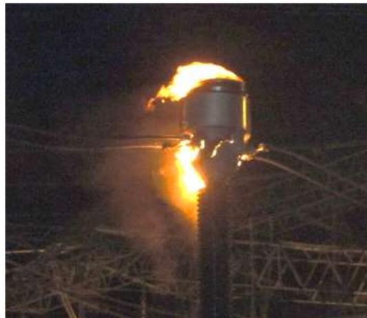
*Figura 2.7 - Exemplo do efeito de uma falha interna em um TC de alta tensão
