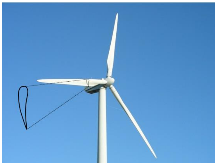
Figura 13 – Seção transversal da pá do aerogerador.
