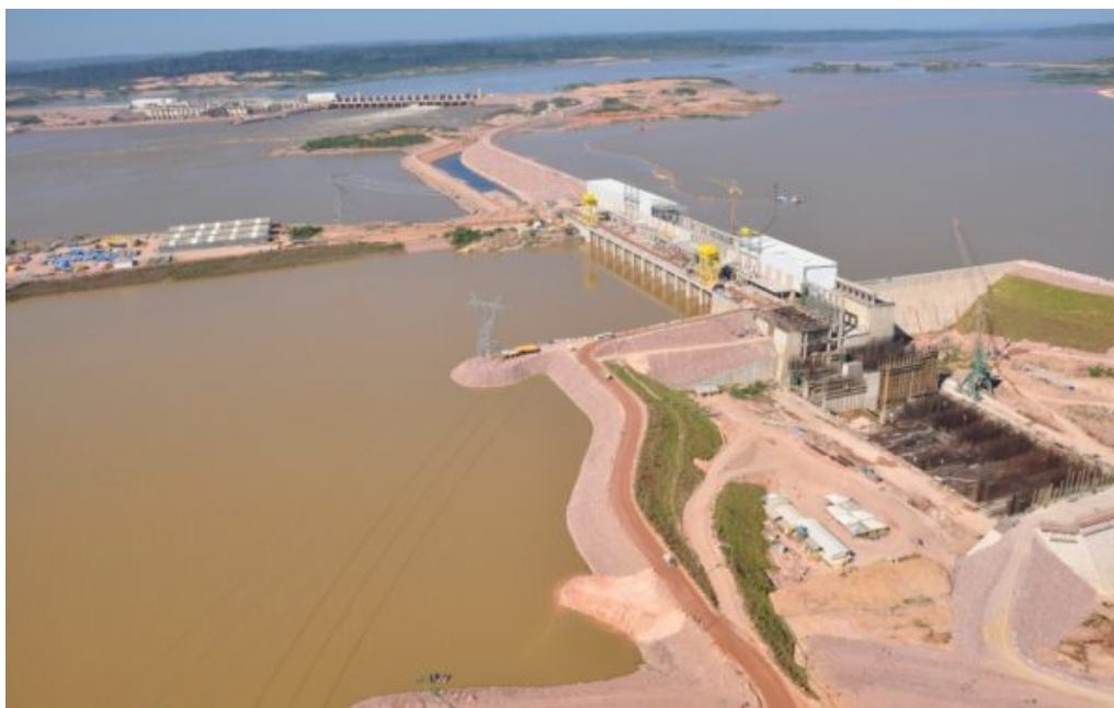
Figura 1.1: Usina Hidrelétrica de Jirau.
