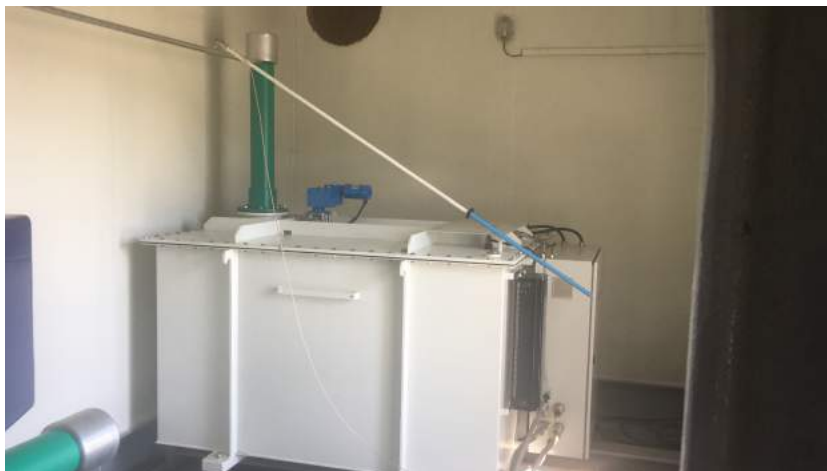
Figura 3.10: Retificador de tensão.
