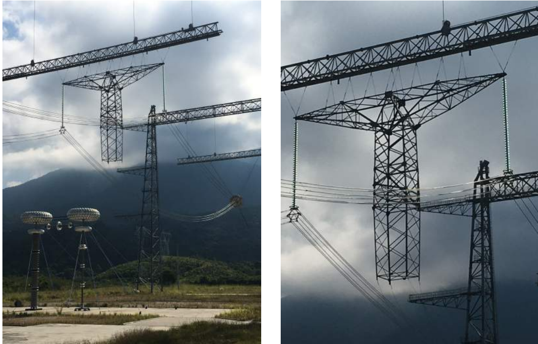
Figura 3.19: Fotos da torre montada e cadeia de isoladores no laboratório UAT
