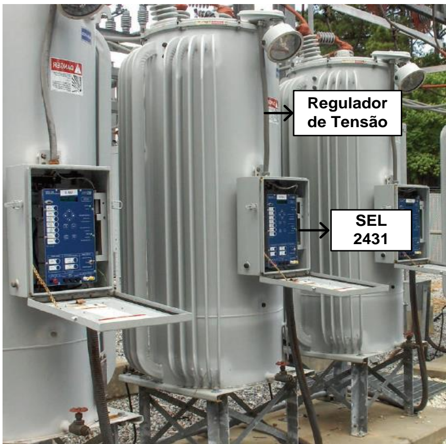
Figura 25: Substituição de um controlador pelo SEL 2431. Adaptado de:[39]
