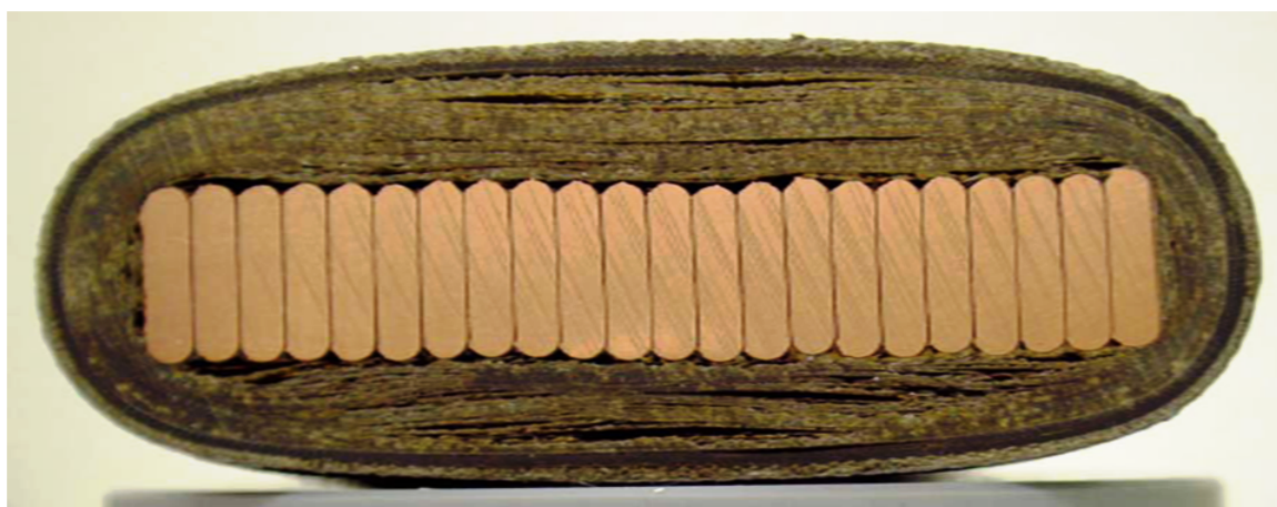
Figura 2.7: Fotografia da seção transversal de uma barra estatórica, onde se podem observar delaminações internas no isolamento.
