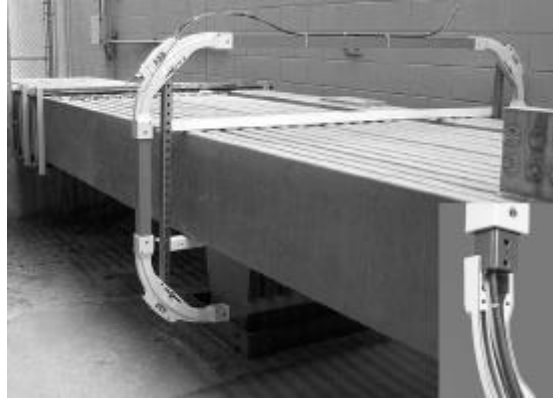
Figura 2.5: Sensor de corrente em fundição de alumínio (adaptado de BOHNERT et al. [21])
