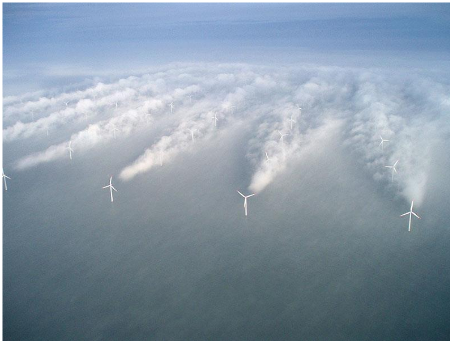
Figura 19– Efeito Esteira em um Parque Eólico
