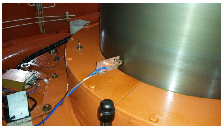
Figura 37 - Tacômetro ótico posicionado junto ao eixo da turbina (centro). Ao fundo é possível ver um acelerômetro montado na tampa da turbina. À esquerda, o condicionador e o banco de baterias.
