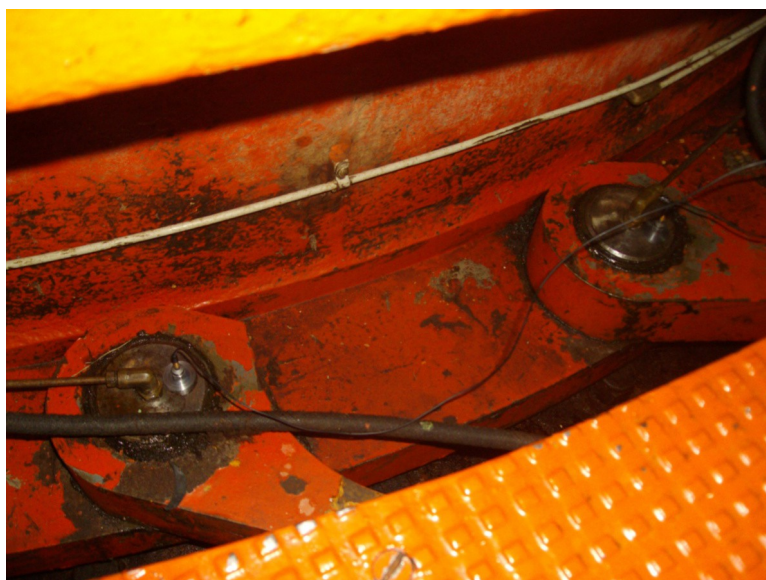
Figura 39 - Instalação dos acelerômetros para a gravação do conjunto de sinais número 2.
