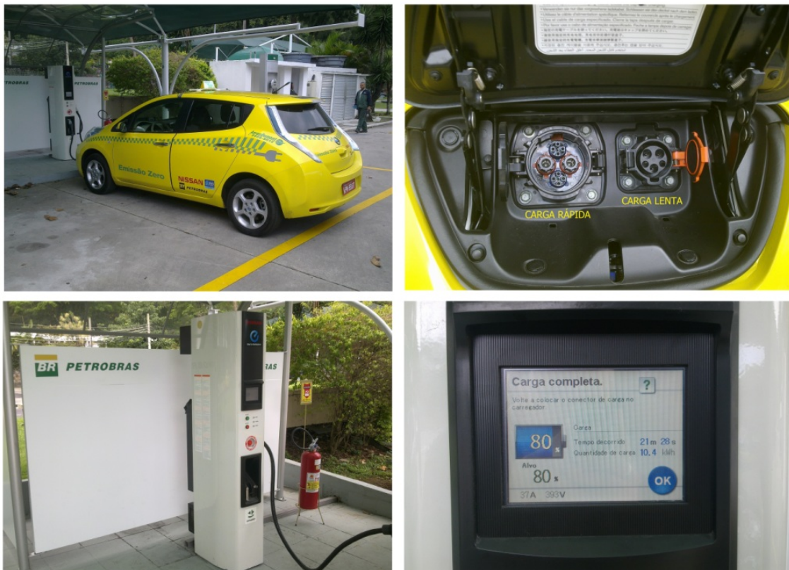
Figura 2.3: Equipamento de carga elétrica.
