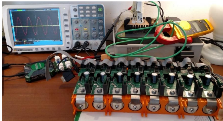
Figura 7.7 Ambiente de teste, conversor, analisadores, transformador e filtro.
