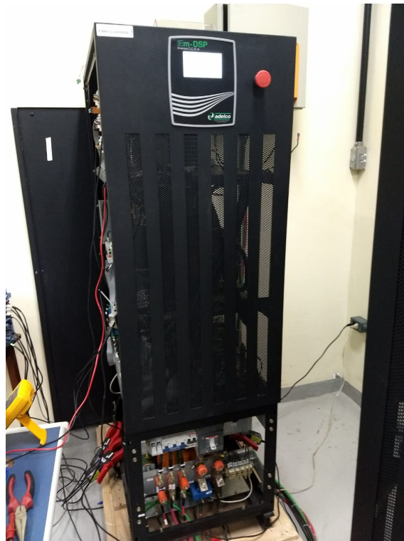
Figura A.5: Conversor Secundário em etapa de comissionamento.
