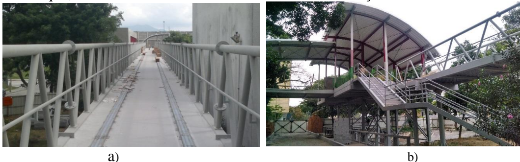
Figura 1.3 – Partes que compõem via elevada. a) Trajeto elevado com trilho de imãs instalados, b) Estação CT-I.
